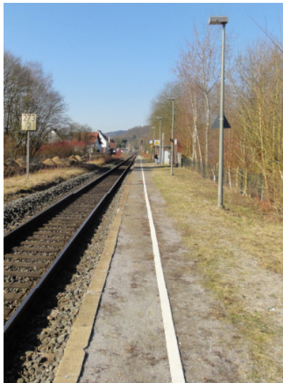
Westheim erhält einen neuen Bahnsteigbelag (hier: alter Belag)
